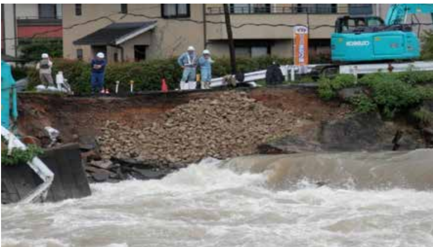
令和2年7月14日の早朝、豪雨により、ゆめタウン裏の仁保川の堰の一部が崩れ、堤防沿いの道路が崩落
